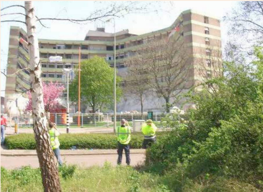
Sloop van de Sterflat van Vijverdal (2007).
